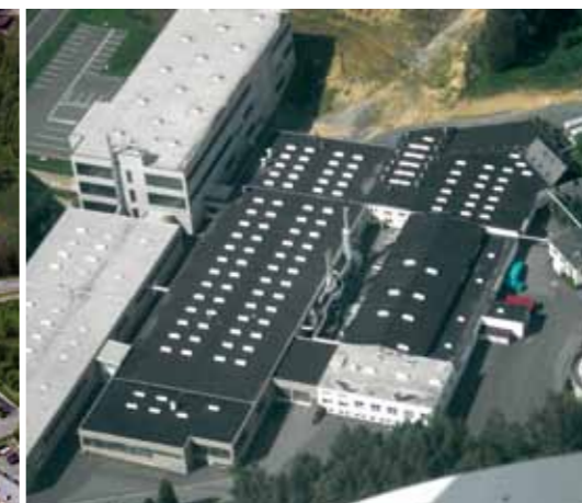
8 Neubau der Drechsel GmbH
