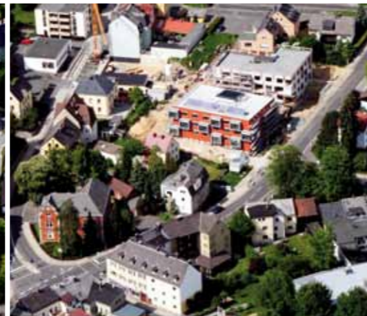
6 Barrierefreie und energiesparende Wohngebäude an der Sedanstrasse
