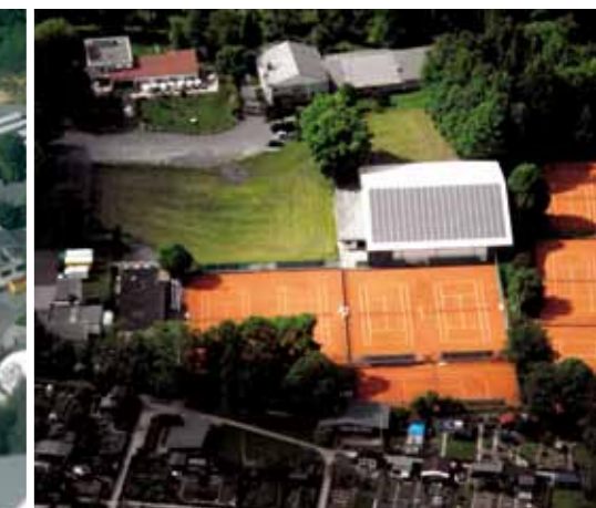
9 Die Solar-Dachanlage des Tennisclub Selb an der Hohenberger Straße.
